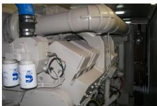
Dauerleistung 800 KVA - 640 KW - 1250 A, 400/ 230 V cos 0,8
